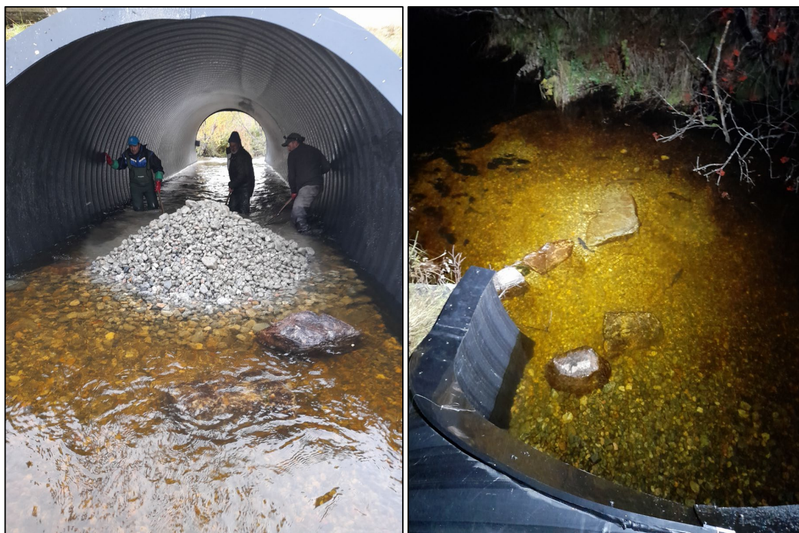
Foto 2.1. Gytegrusutlegging i Veaelva i den østlige grenen av Straumevassdraget. a) Arbeidet med utlegging av grus. b) Ferdig utlagt gytegrus med laksefisk som står på utleggingsområdet. Begge foto: Knut-Einar Søberg.
